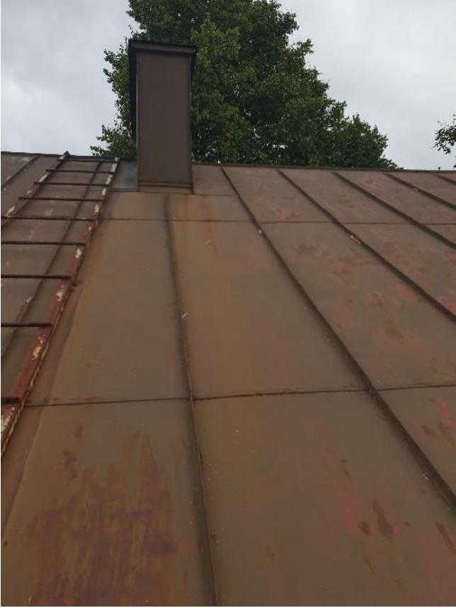
Asuinrakennuksen katto. Savupiipun saumapelti on tiivis.
